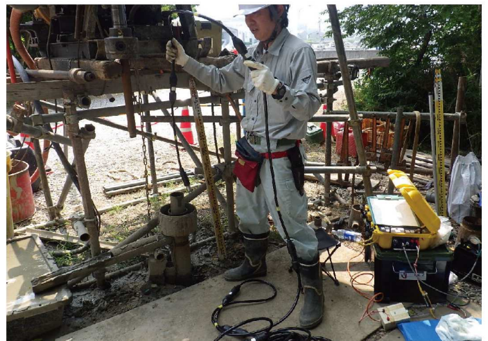
ボーリング孔への挿入状況
